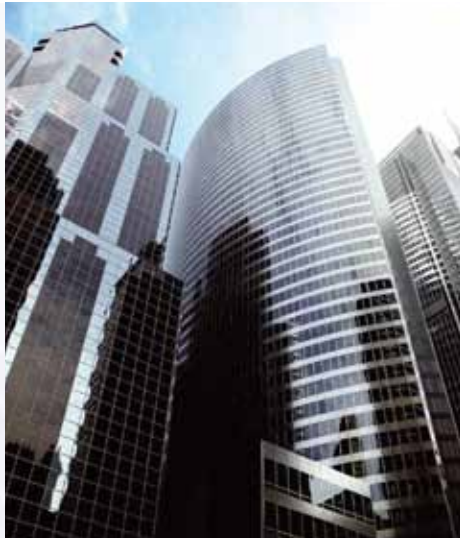
「スマート」なビル先進技術の最大の応用先はオフィスビルだ。
